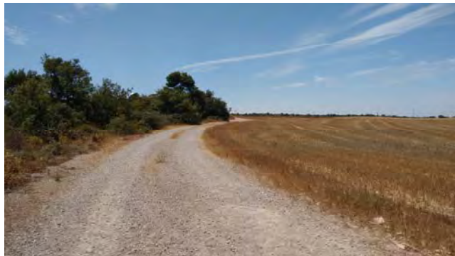
Figura 7. Capa de rodadura de tot-ú
